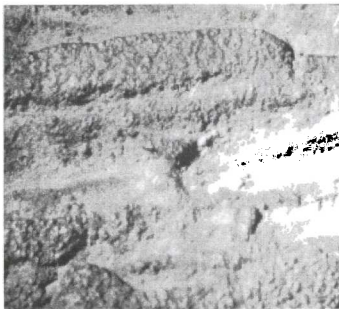
FIGURA 6 "Peinado" sobre el material de relleno
