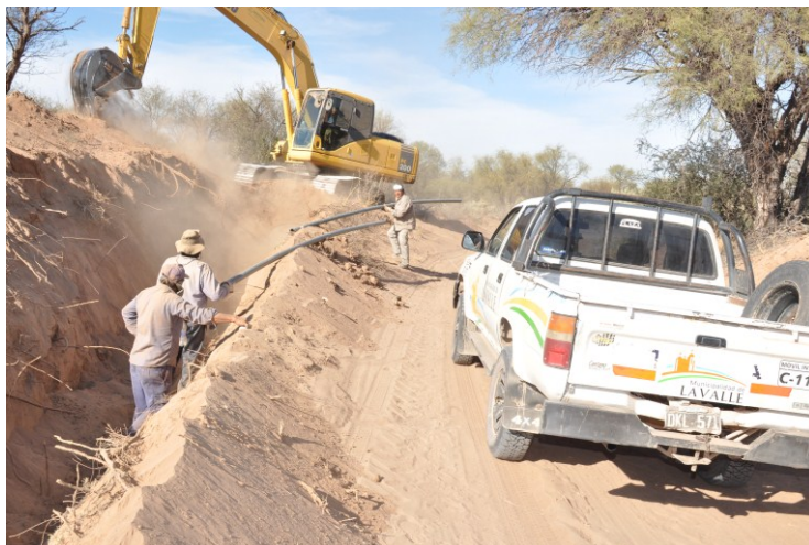
Figura IV.23. Etapa de construcción de la red madre del acueducto
