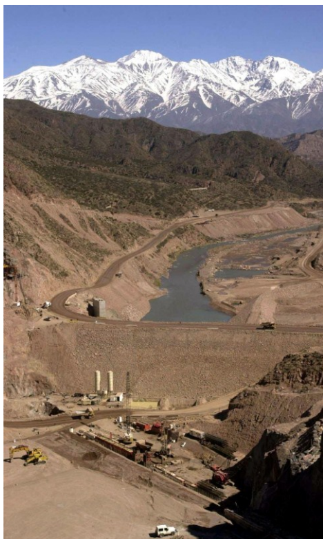
Figura IV.11. Construcción del dique Potrerillos
