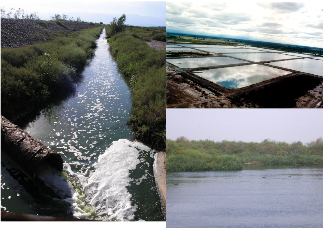
Figura V.12. “Canal de fuga”, piletas originales y nuevas lagunas ubicadas al este del establecimiento
