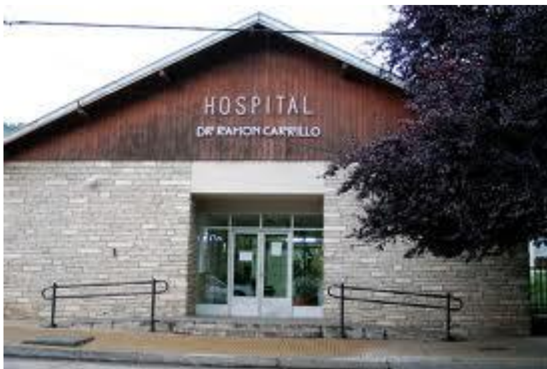
Figura III. Hospital Ramón Carrillo de San Martín de los Andes.
