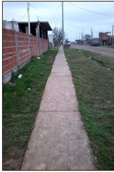
Vereda colectiva de cemento. Imagen 2016.
