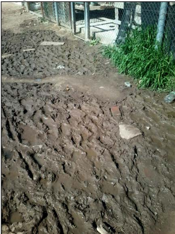
Improvisación de saltos sobre tramos anegados.
