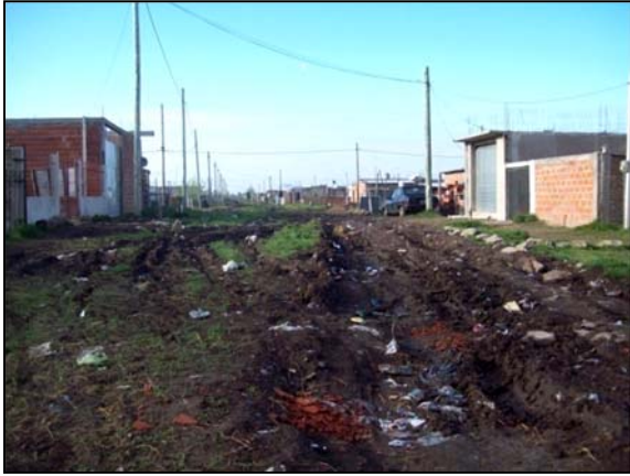
Utilización de escombros y residuos para consolidación de calles internas. Imagen 2015.
