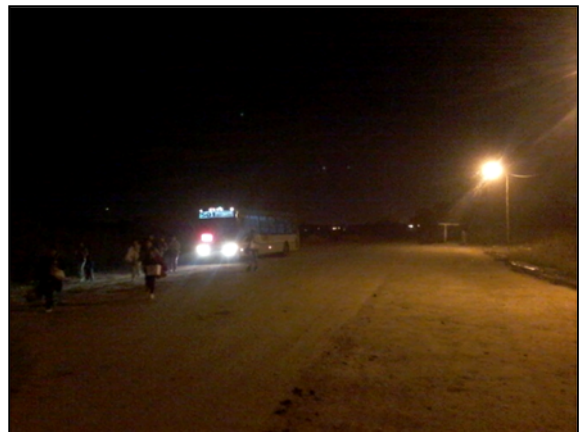
Faroles de alumbrado público municipal instalados en la entrada del barrio.
