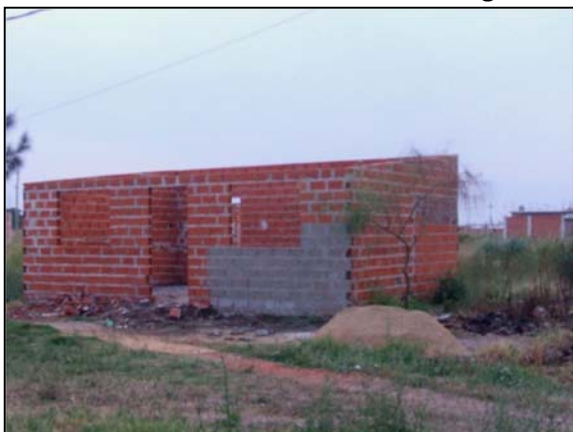
Lote con vivienda en construcción.
