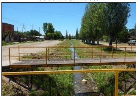
Puente sobre el A° Sta. Catalina en el barrio El Píal.
