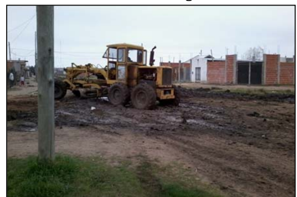
Contratación de maquinaria para nivelación. Imagen 2016.
