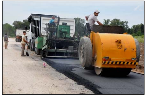
Tareas de pavimentación de acceso a La Victoria. Fuente: Clarín zonal E. Echeverría, 03-dic-2012.
