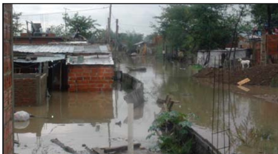
Inundación en el barrio La Palangana de Laferrere. Fuente: Ezequiel Peralta, www.ezefotografia.com
