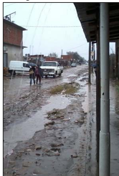
Circulación peatonal por la calle por anegamiento de vereda. Imagen 2015.
