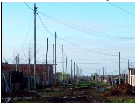
Postes de tendido eléctrico en La Victoria.
