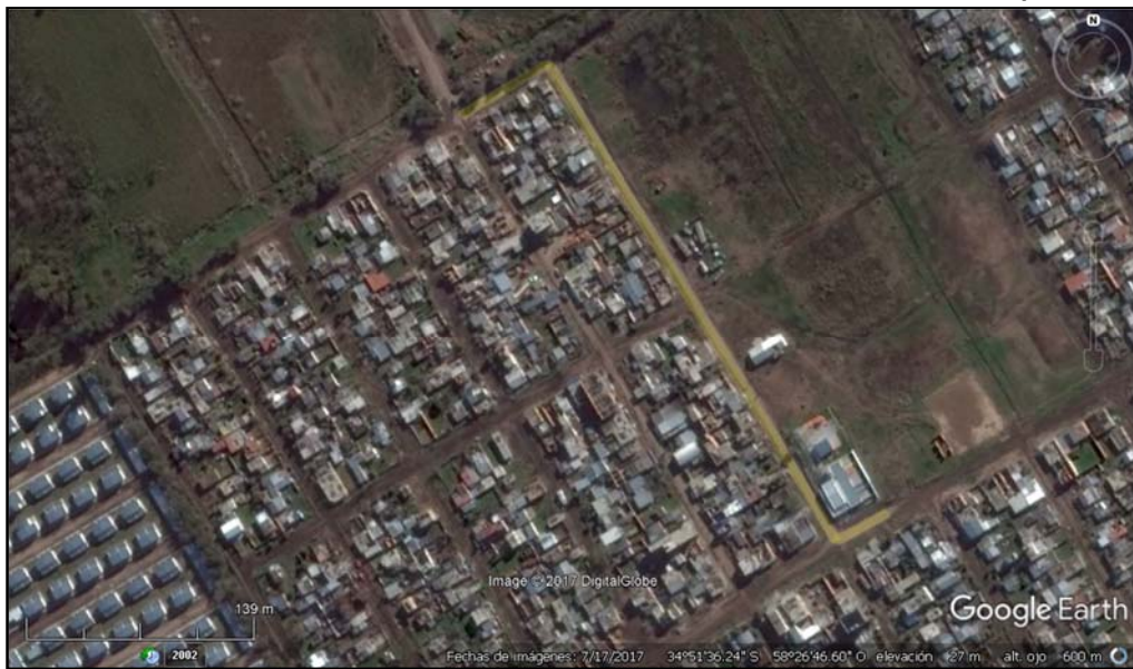
Figura 6-39. Tramo interno de acceso a Jardín de Infantes N° 936 recientemente pavimentado.
