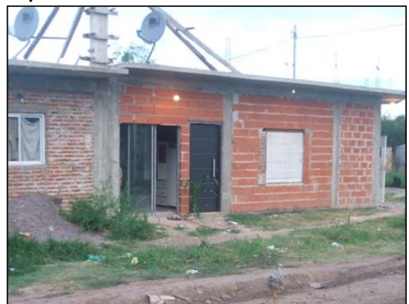
Casas de material sin revoco.
