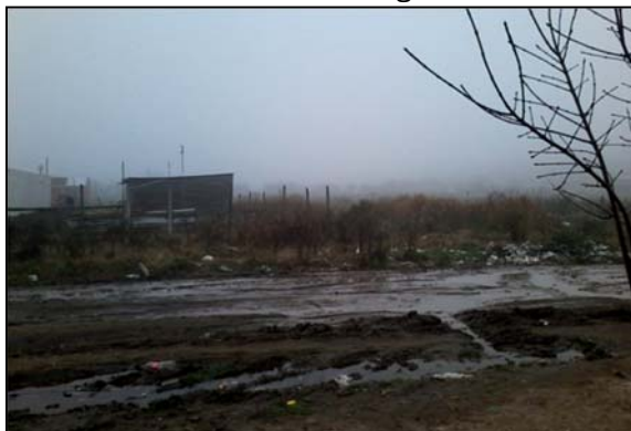
Apertura de zanja para drenar calle anegada. Imagen 2015.
