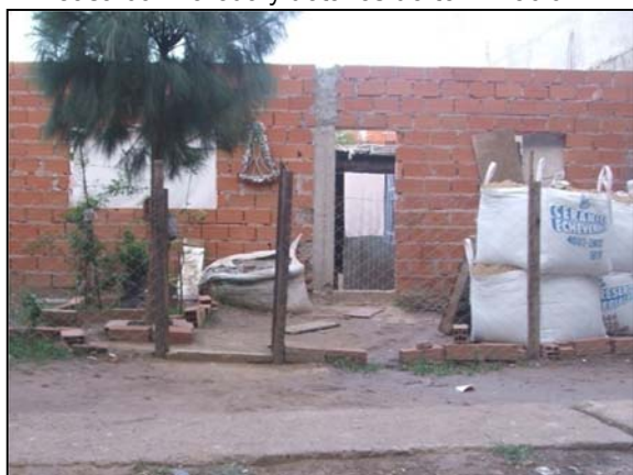
Casilla con casa de material en construcción.
