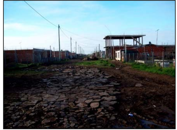
Utilización de restos de pavimento para consolidación de calles internas. Imagen 2015.
