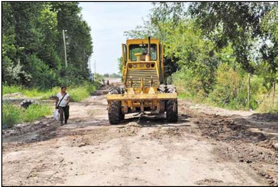
Tareas de pavimentación de acceso a La Victoria. Fuente: Clarín zonal E. Echeverría, 09-dic-2012.
