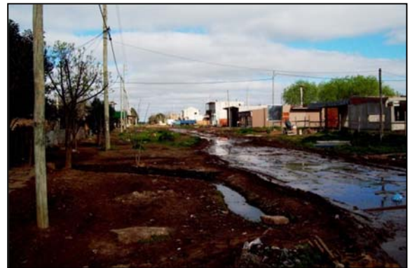
Anegamiento de calle interna de La Victoria. Imagen 2015.
