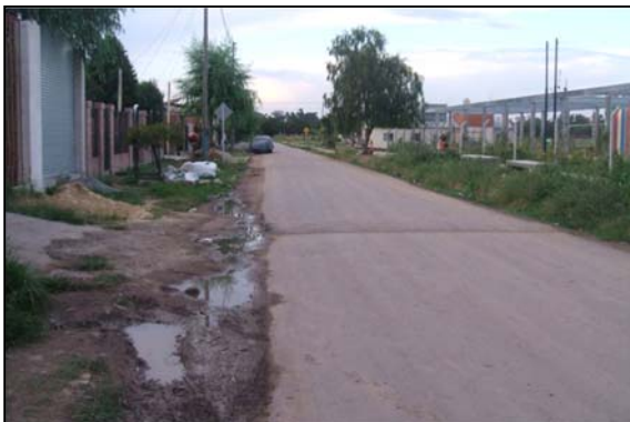
Pavimentación de calles de acceso al Jardín de Infantes N° 936.
