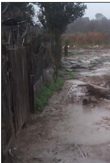
Lotes sin veredas durante días de lluvia. Imagen 2015.
