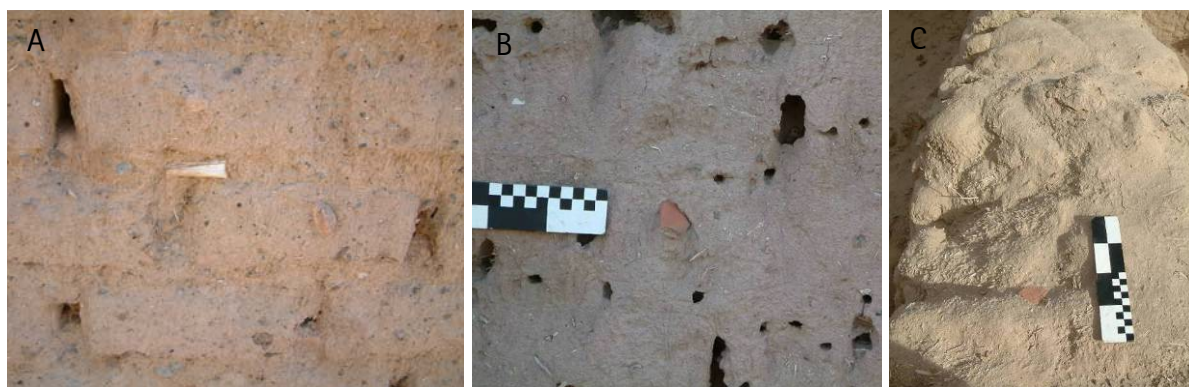
Figura 8.56. Detalle de inclusión de materiales en los adobes y el mortero. A) material óseo y lítico en Casa de Felipe Varela (Guandacol); B) tiestos cerámicos en El Condado (Villa Castelli); C) tiestos cerámicos en Las Bateas 4 (Villa Castelli).
