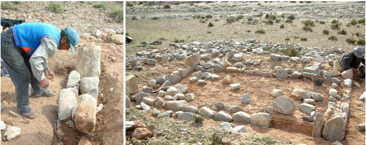
Figura 4.2. Realización de cimientos de piedra, de lienzo doble con mortero, en la localidad de Susques, Puna jujeña.
