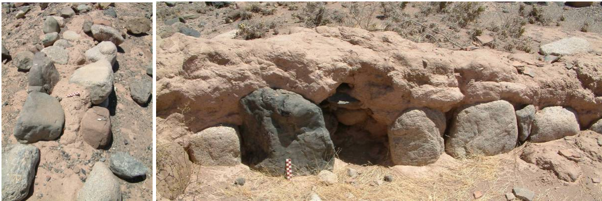
Figura 7.30. Detalle de cimientos de piedra de las Tamberías de Guandacol
