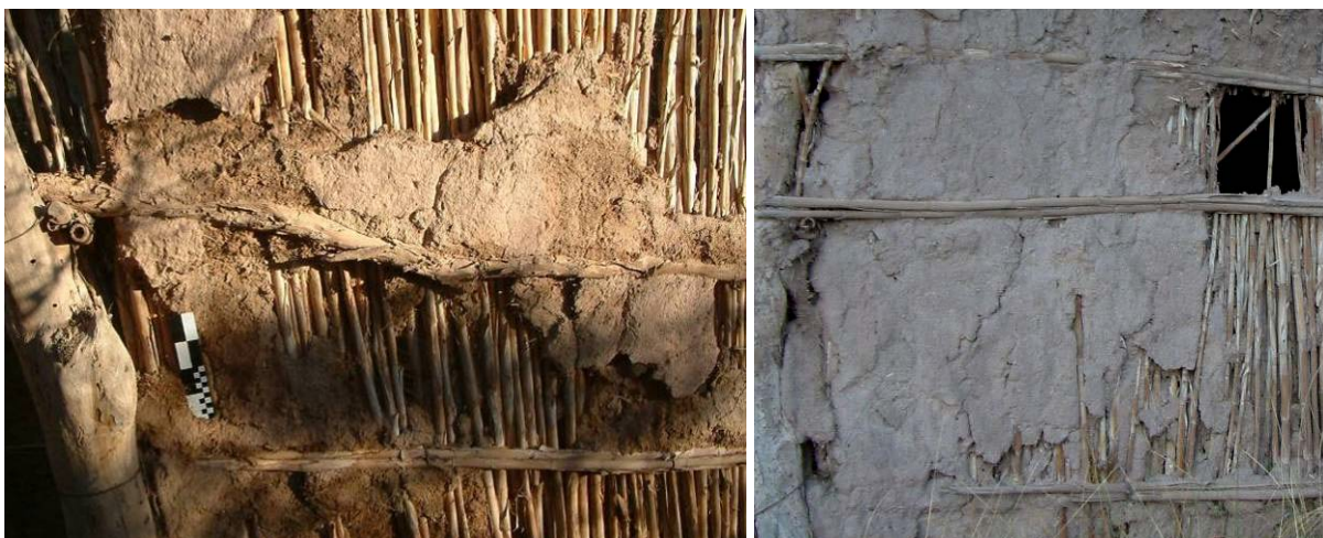
Figura 8.68. Muro de quincha de cañizo. La Aguadita 7 (Villa Castelli)
