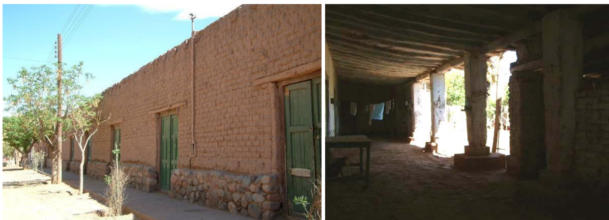
Figura 8.34. Vista de la fachada y de la galería interior de la casa de la Sra. Lilia Dávila en Banda Florida
