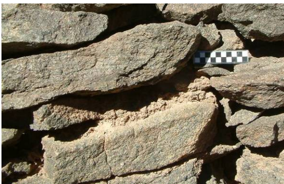
Figura 7.37. Detalle muro de piedra con mortero de barro. Fortaleza del Co. El Toro
