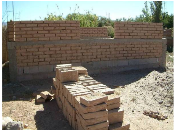
Figura 9.5. Casa en construcción con bloques de cemento y adobes. Villa Castelli
