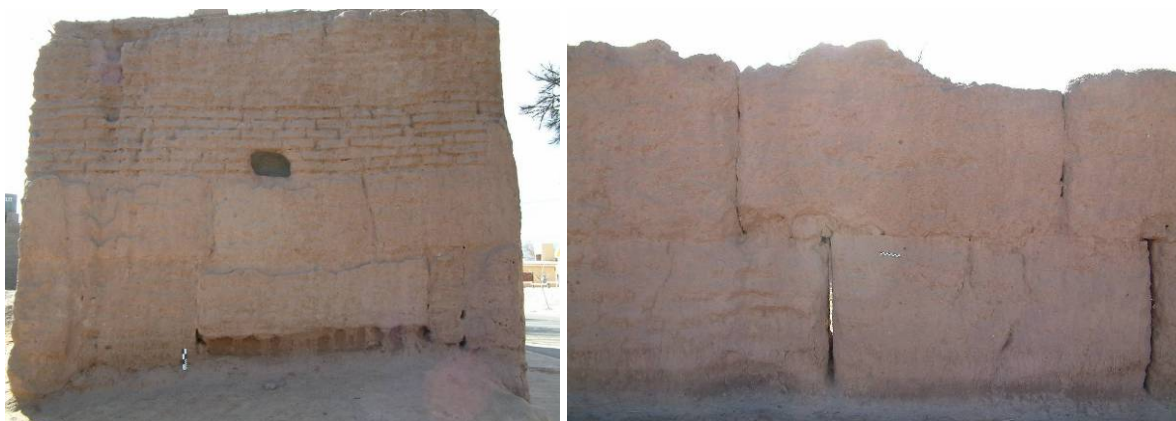
Figura 8.53. Detalle de muro de tapia. A la izquierda en Villa Castelli; a la derecha en Vieja Vinchina
