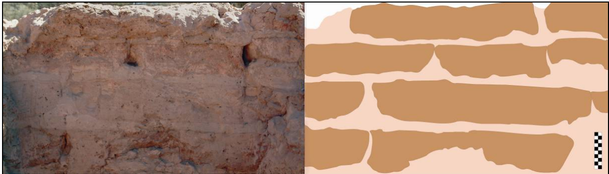
Figura 7.39. Detalle de aparejo murario con mampostería de adobe de la esquina Norte del R3. Las Taperas
