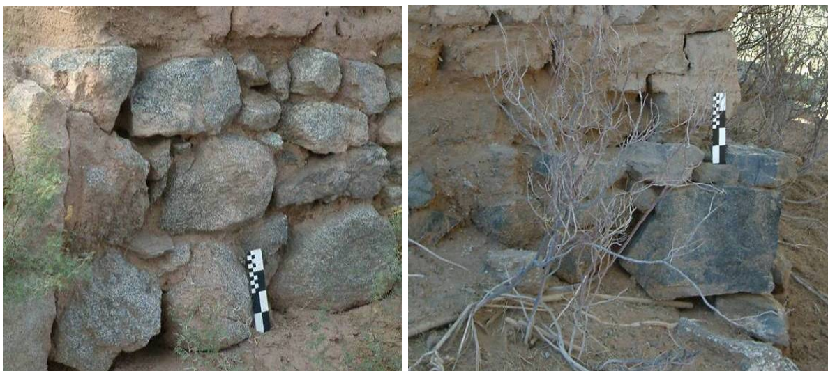
Figura 8.50. Detalle de sobrecimientos. A la izquierda El Condado; a la derecha Vallecito 4
