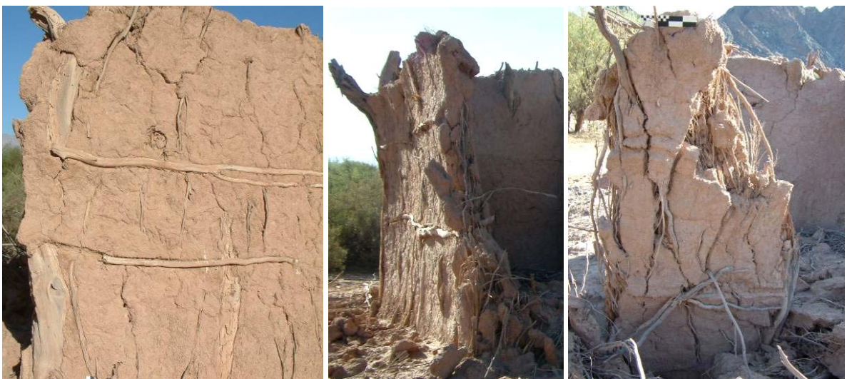
Figura 8.67. Muros de quincha con ramas de lata. Parecitas 9 (Villa Castelli)
