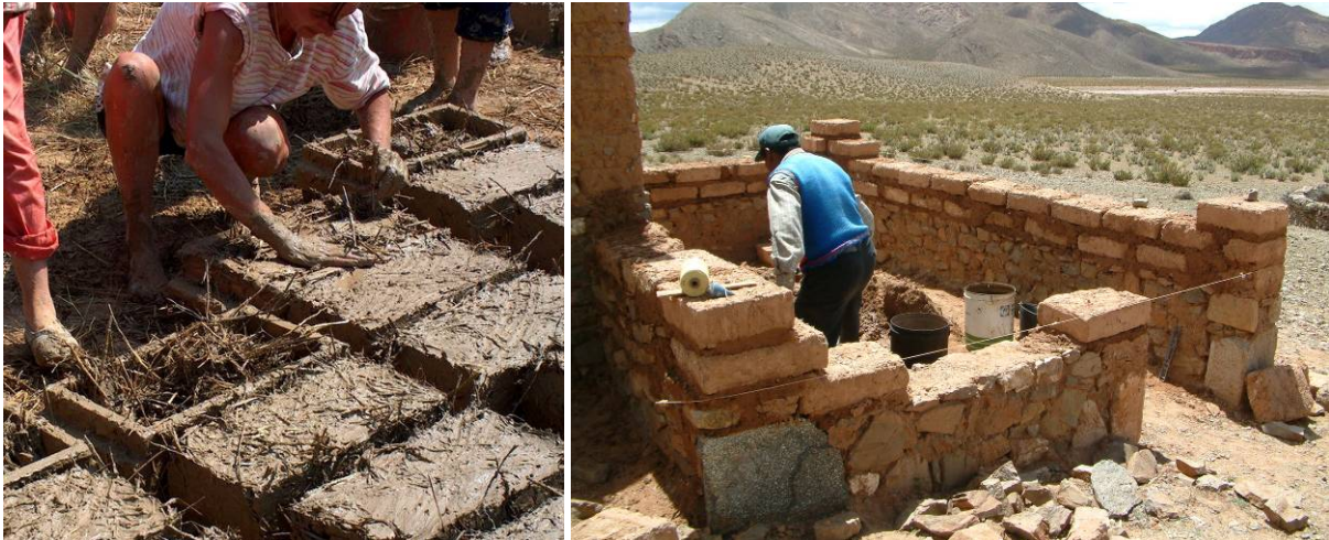
Figura 4.5. Construcción con adobe. A la izquierda, confección o cortado de ladrillos de adobe en Rumania (tomado de http://upload.wikimedia.org/wikipedia/commons/2/2a/RomaniaDanubeDelta_MakingMaterialForCOnstructing0002jpg.jpg ). A la derecha, construcción de muros de adobe sobre fundaciones de piedra en Susques, Puna jujeña.
