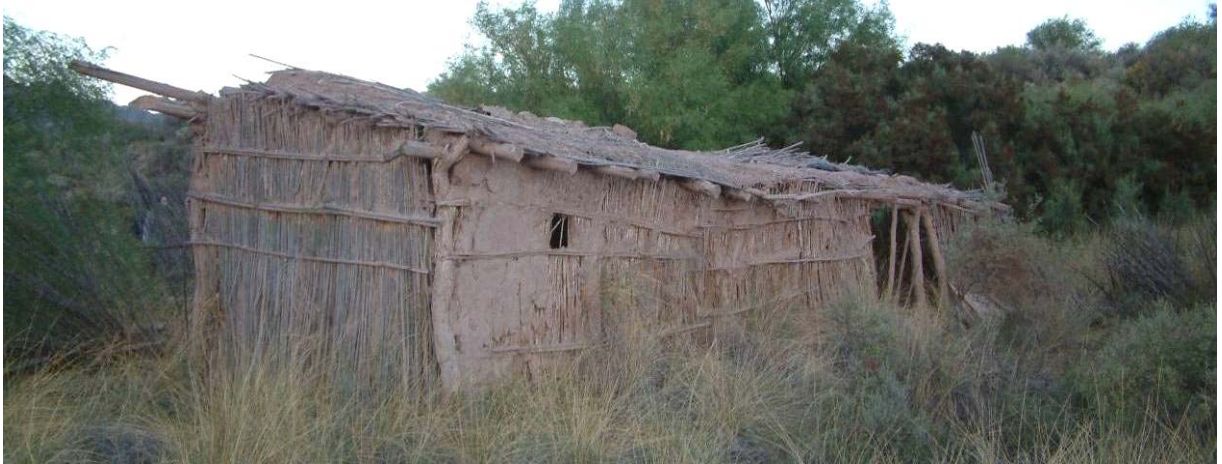
Figura 8.23. Vista Sudeste de la casa de quincha de La Aguadita 7
