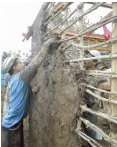
Figura 4.6. Construcción con entramados de cañas y barro en Panamá (tomado http://mensual.prensa.com/mensual/contenido/2007/01/06/hoy/nacionales/789574.jpg )
