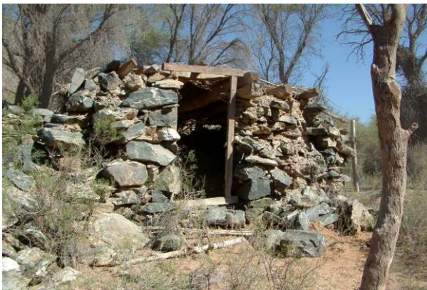
Figura 8.18. Detalle de recinto construido en piedra
