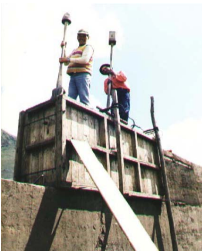
Figura 4.4. Construcción con tapial en Ecuador (tomado de Romero 2006)
