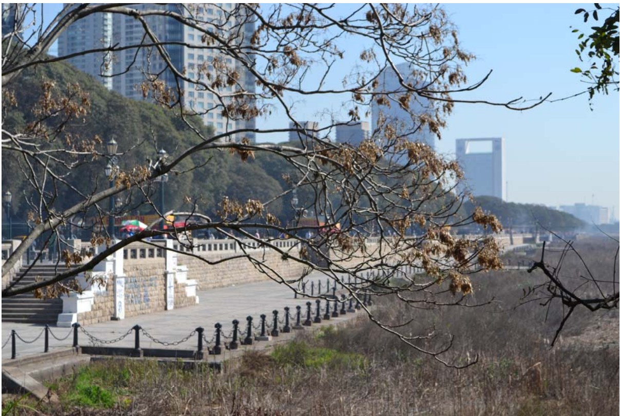
Fig. Nº 6, 2013. Costanera Sur, huellas del Balneario Municipal reconocidas desde el camino de acceso a la reserva. Fuente: elaboración propia
