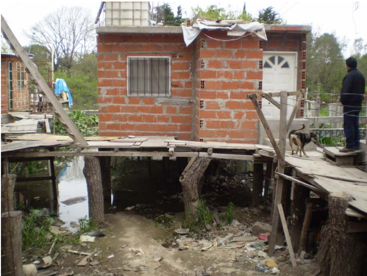
Fig. Nº 47, 2011 , interior asentamiento Rodrigo Bueno. Sector sobre el arroyo.
