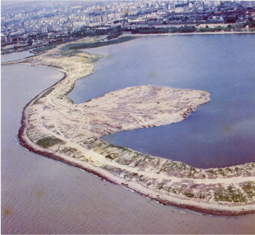
Fig. Nº 34, 1980, comienzo de las obras de relleno con los terraplenes perimetrales. Fuente: Archivo Municipalidad de Buenos Aires.
