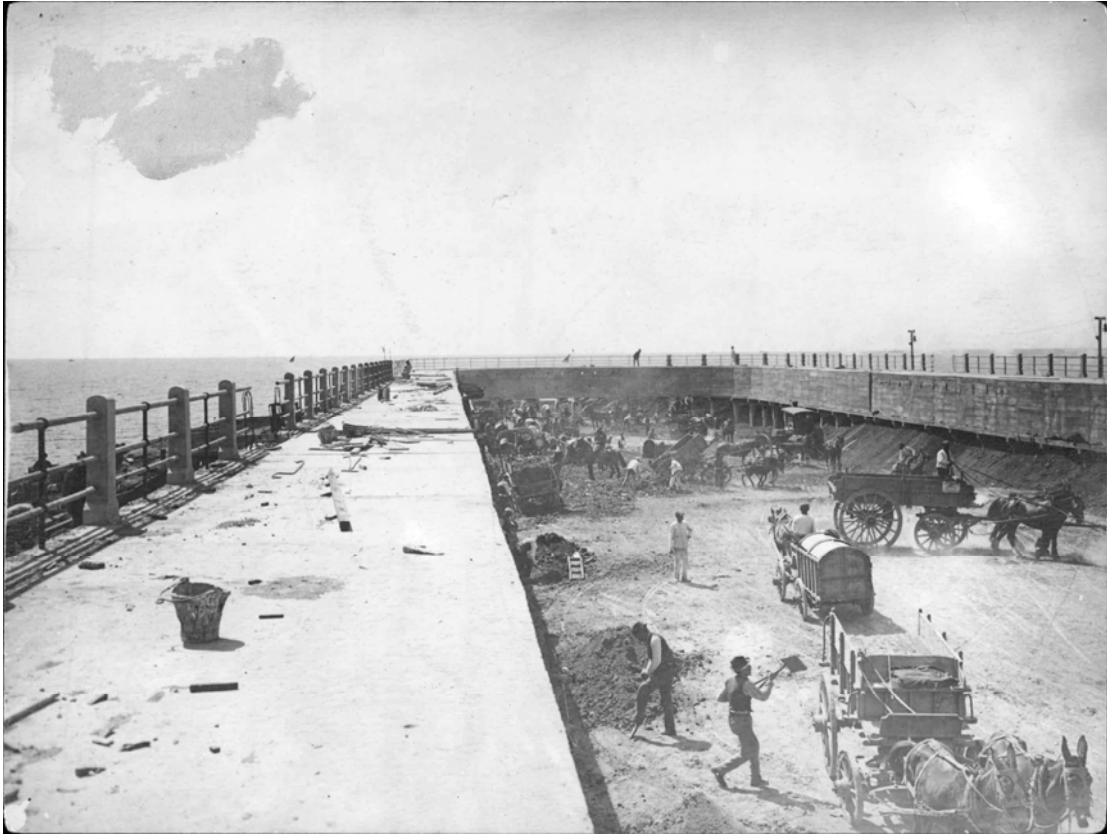
Fig. Nº1, c 1918, construcción del espigón en el Balneario Municipal de Costanera Sur. Fuente: Archivo General de la Nación Departamento Documentos Fotográficos. Buenos Aires. Argentina
