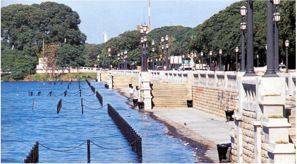
Fig. Nº40, 1999 , obras de rehabilitación de la costanera que incluyeron la limpieza de la Laguna de los Coipos.
