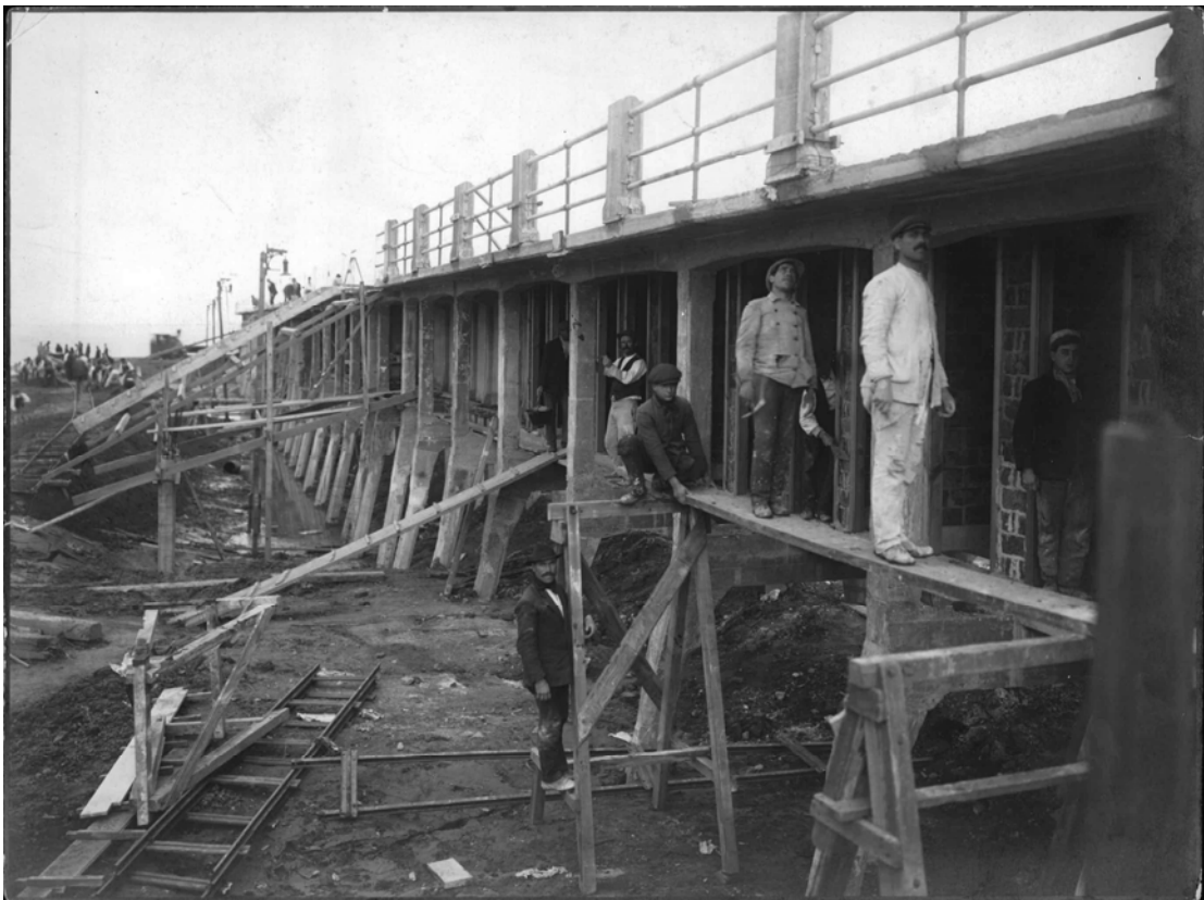
Fig. Nº2, c 1918, construcción espigón y vestuarios, Costanera Sur. Fuente: Archivo General de la Nación Departamento Documentos Fotográficos. Buenos Aires. Argentina
