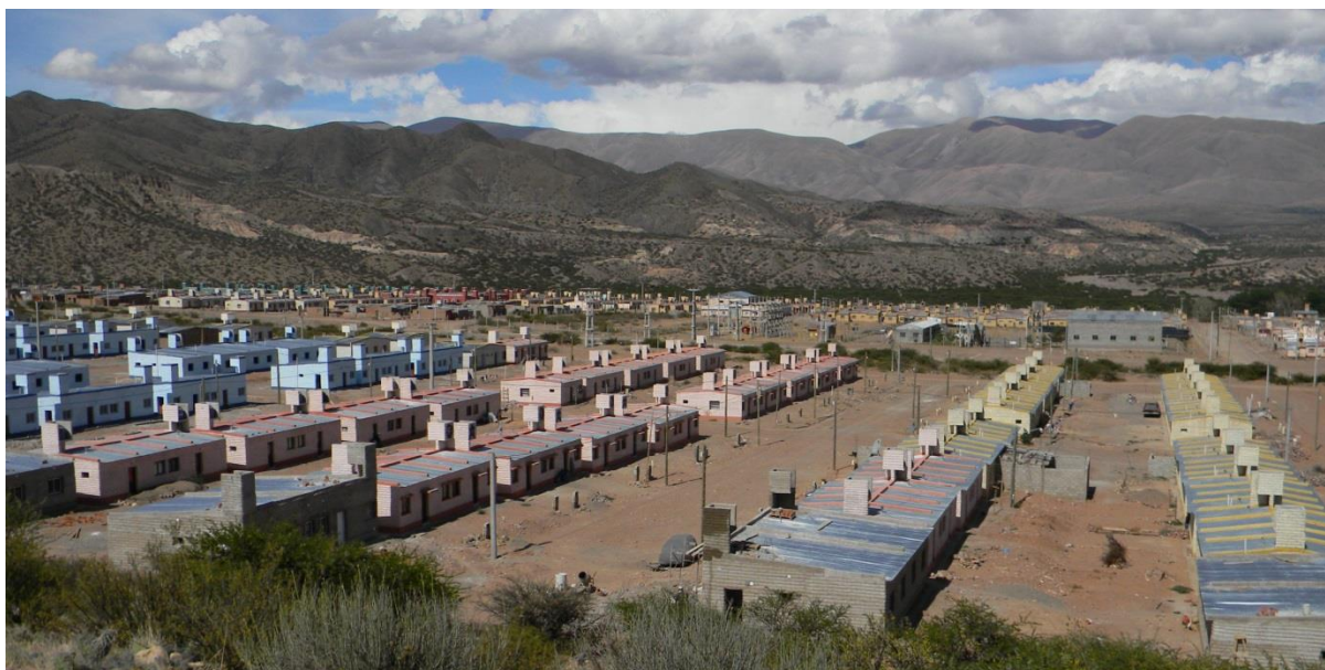
Figura 50: 2 de Abril visto desde el oeste. Fuente: Fotografía propia tomada en diciembre de 2011.
