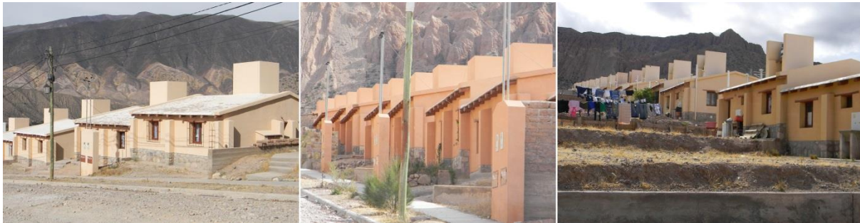
Figura 90: Viviendas del PFCV ejecutado en Sumay Pacha. Fuente: Fotografías propias tomadas en mayo y diciembre de 2011.
