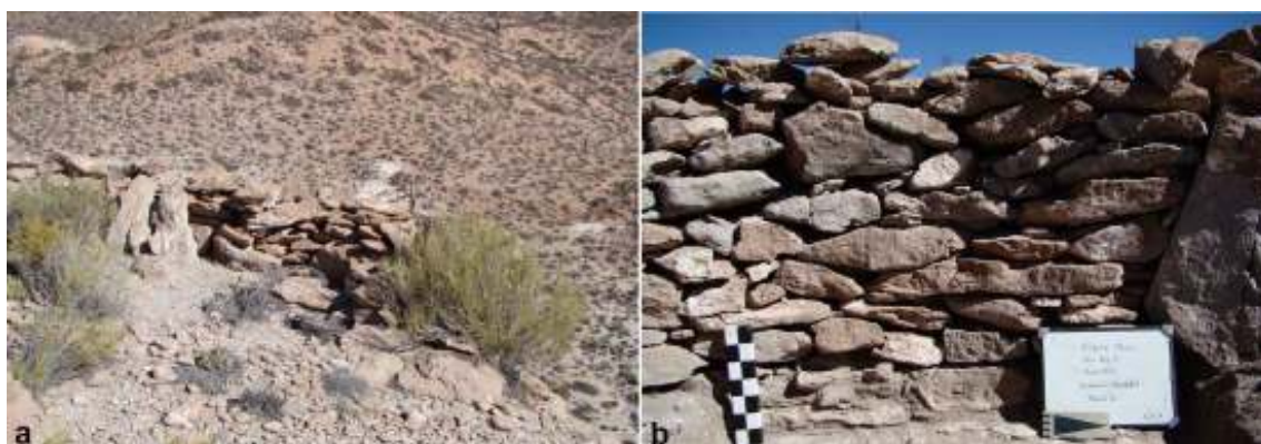
Figura 5.5. Fuerte Tacuil. a) parte de la muralla perimetral; b) muro Oeste del Recinto 9 de la Div. Arq. E del Fuerte (fotos cortesía V. Williams).
