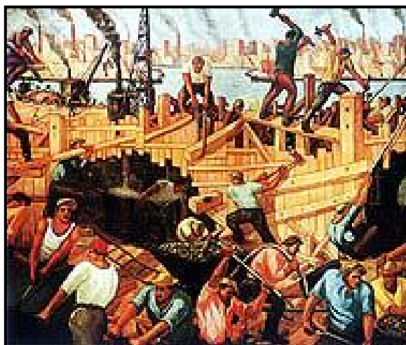
Figura 6.6: “Desagües Pluviales” Pintura mural de Benito Quinquela Martín realizada en el año 1937.
