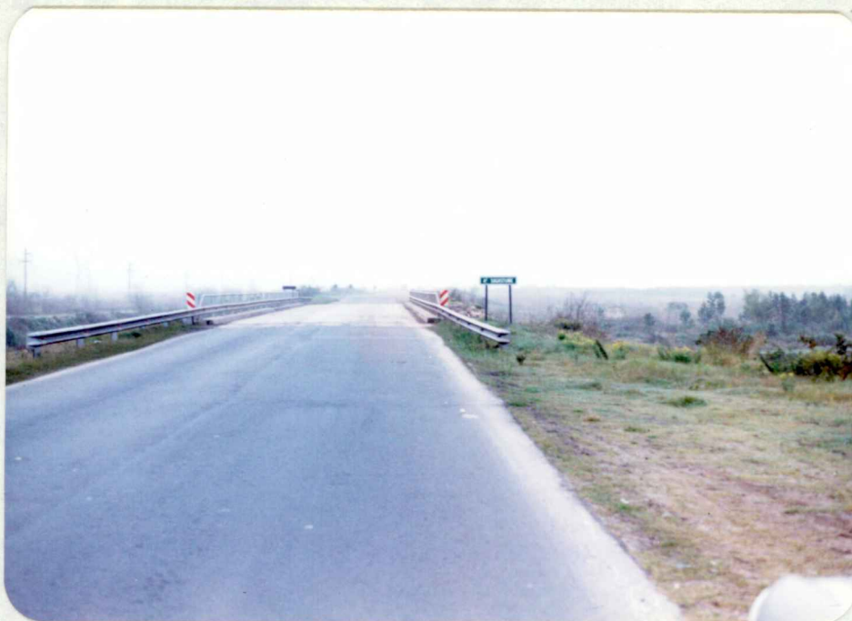
Foto número 39 : Puente sobre el Arroyo Sagastume en la ruta nacional número 12 que fuera destruído en ocasión de las inundaciones de 1982/83
