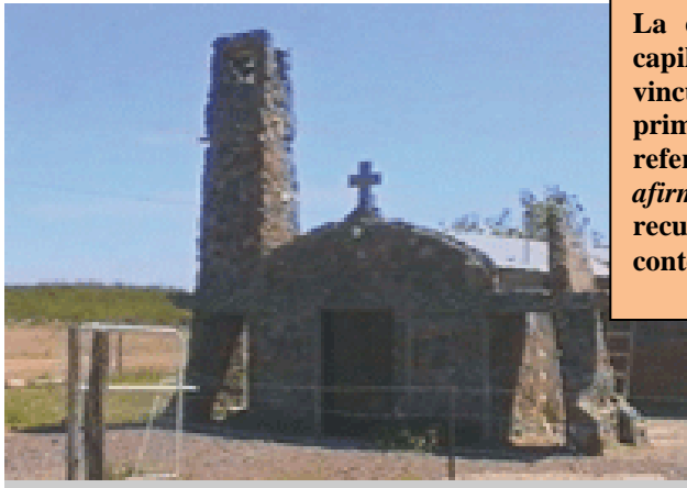
24. Capilla antes de la intervención
