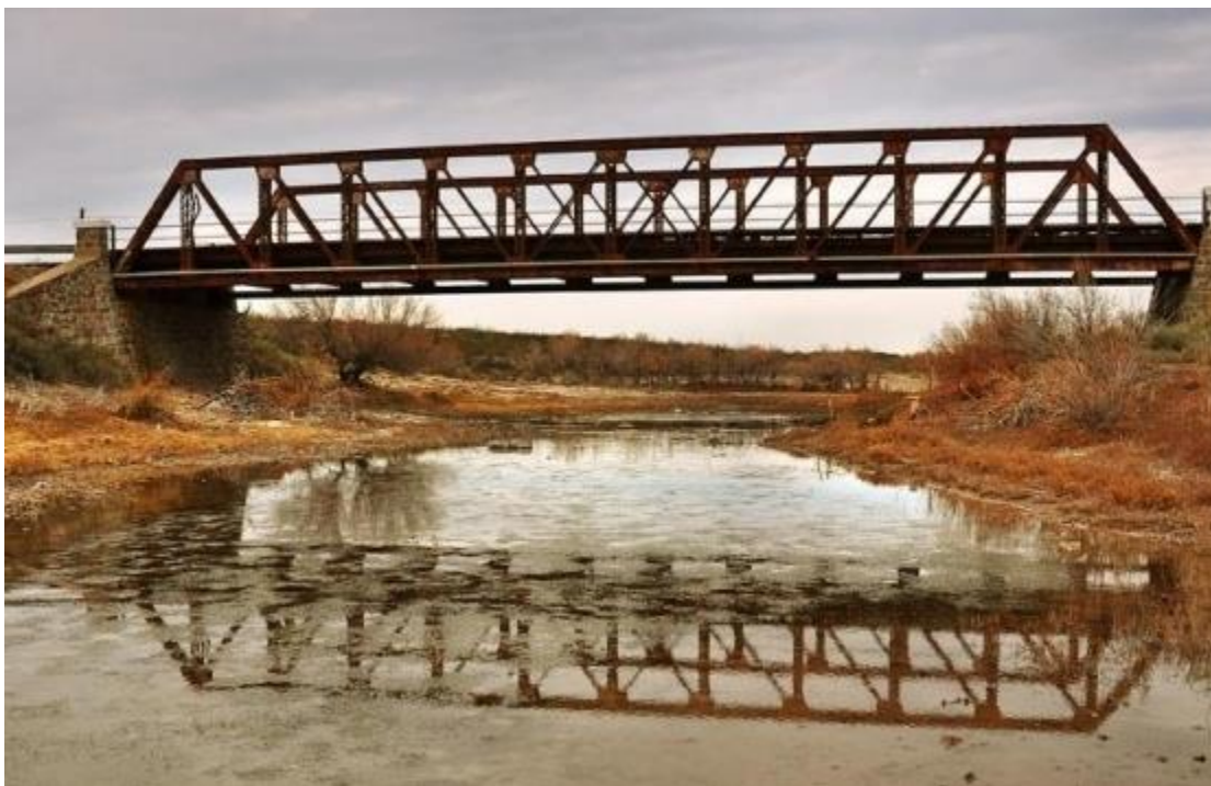
13. Puente sobre el Río Salado a la entrada de Puelches, construido en 1928
