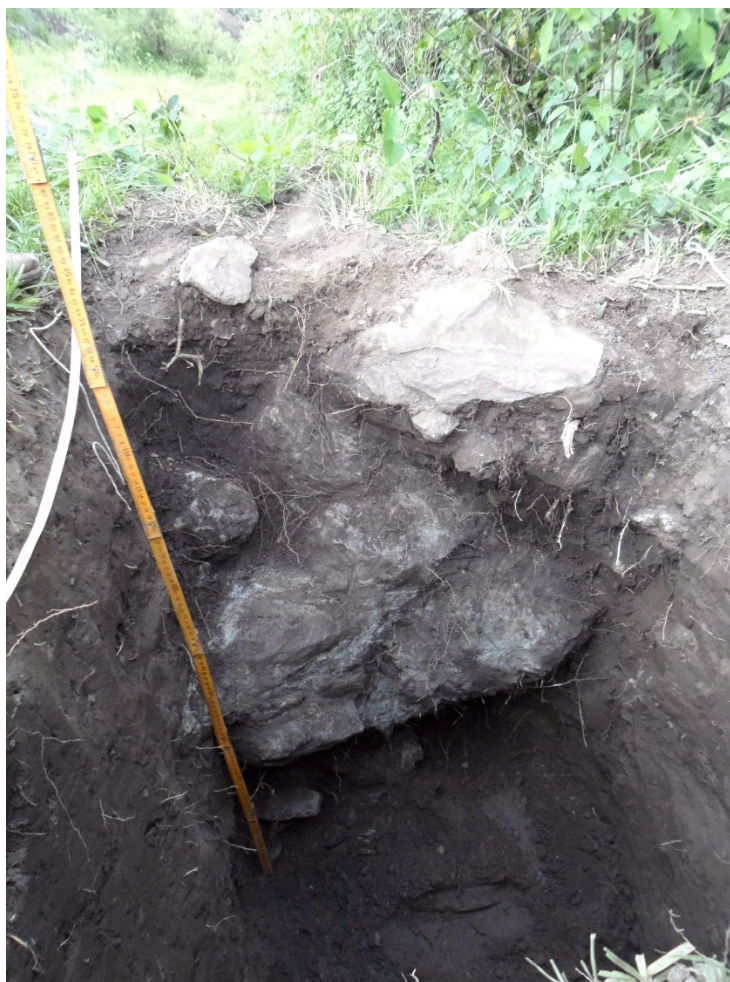
Figura 5: calicata realizada en una terraza de Oyola.
