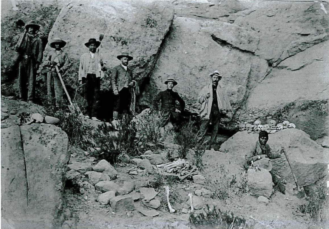
Figura 2. Excavaciones en La Poma por Manuel B. Zavaleta (Zavaleta 1906:299)
