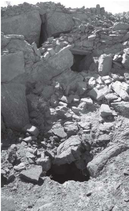
Figura 16. Entrada a túneles en la Fortaleza del Cerro El Toro.
