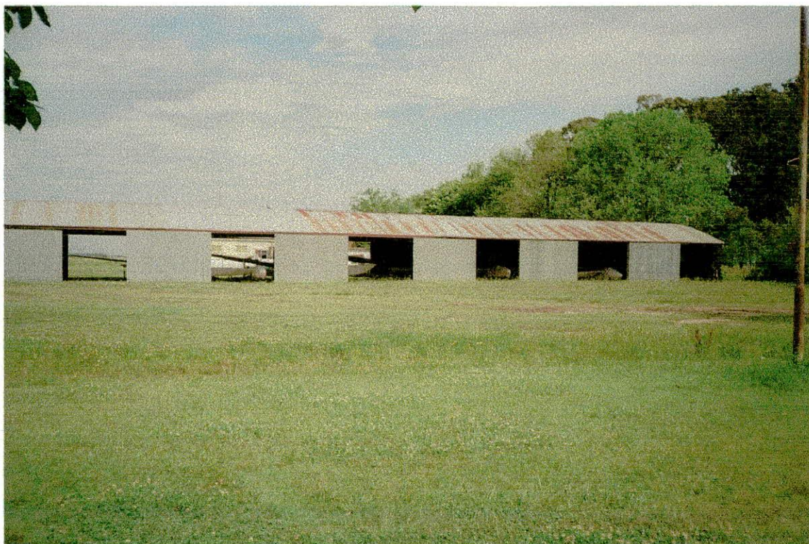
Foto 17: Hangar para planeadores en el Aeródromo de Cañuelas.
