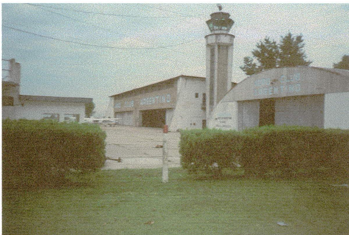
Foto 18: Torre de control y hangar principal del Aero Club Argentino en el Aeródromo de San Justo.
