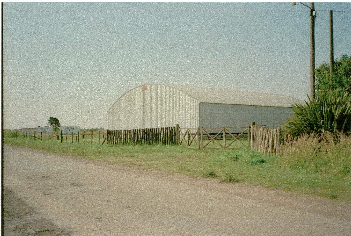
Foto 34: Hangar principal del Aeródromo de Puerto Chenaut.
