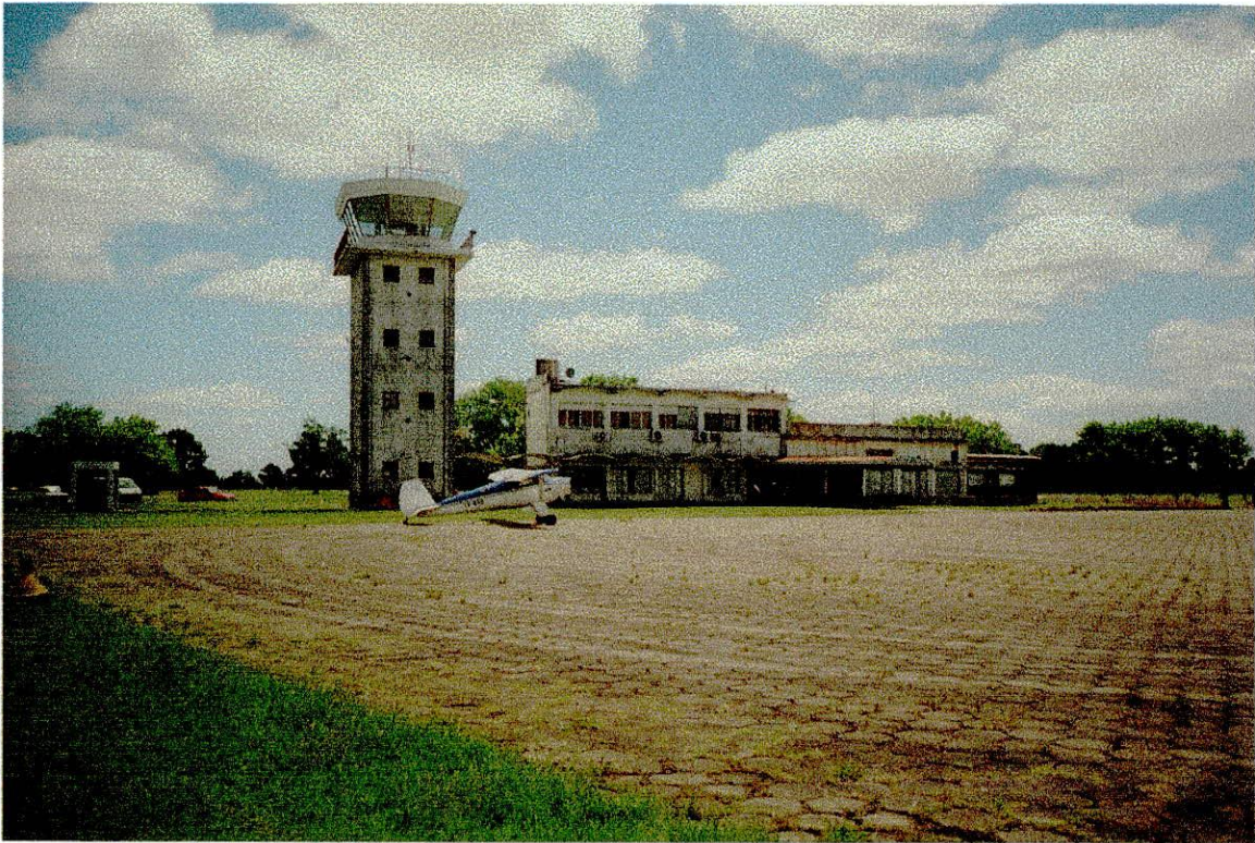
Foto 13: Plataforma principal, torre de control y terminal de pasajeros del Aeródromo de La Plata.
