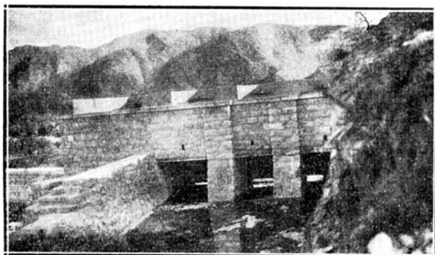
Foto 12.—Las tres boca-tomas del canal alimentador que parte de la presa del río Quines. Obra ejecutada por el gobierno provincial. Foto tomada desde aguas abajo.
