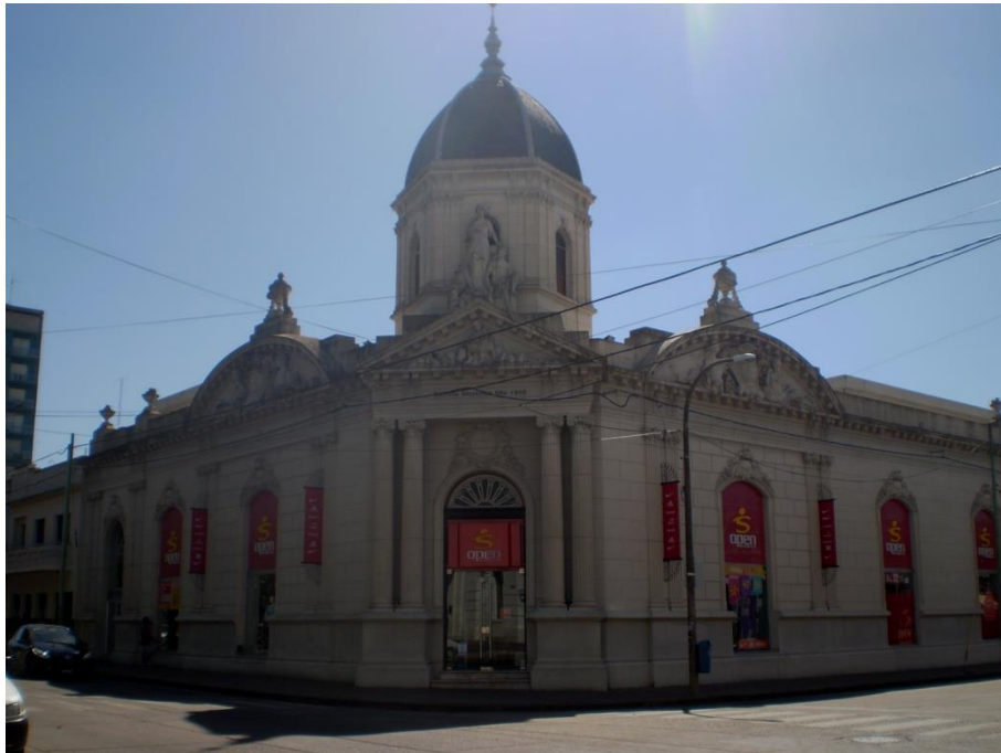
Imagen 17. Edificio del ex Banco Olavarría, Olavarría, 2016
